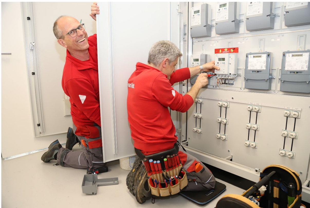
Markus Küttel und Othmar Camenzind vom Team Rot beim Ersetzen der herkömmlichen Stromzähler durch Smart Meter.
