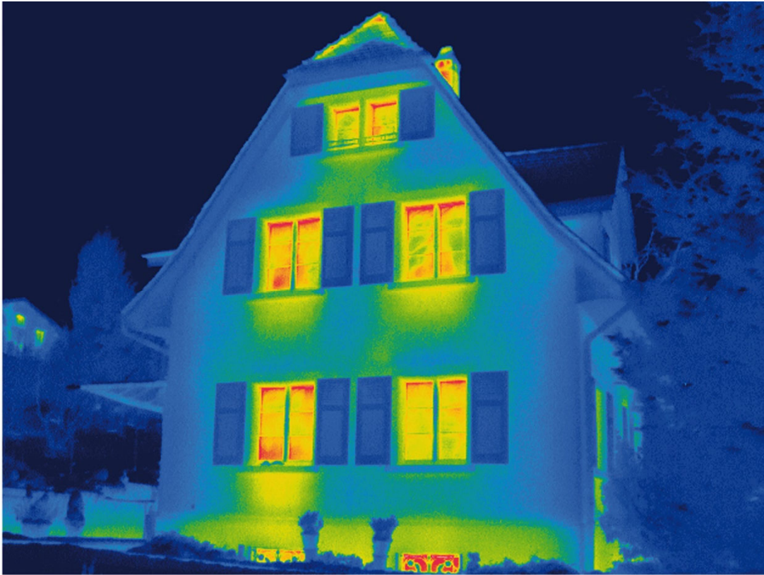
Wärmebildaufnahme eines Wohnhauses: Die gelb-roten Bereiche zeigen deutlich, wo Wärme über Fenster und Fassaden entweicht.
